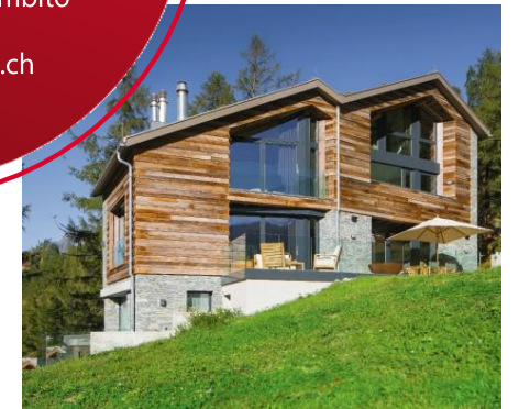
CERVO Mountain Boutique Resort, CH-Zermatt Arquitecto: MLS-Architekten, CH-Zermatt Operador / Inversor: Familie Lauber, CH-Zermatt
