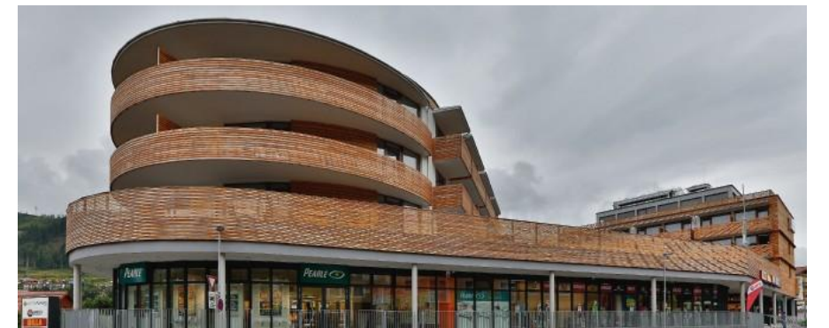
Hotel Planai, A-Schladming Operador: Familie Rölle, A-Schladming Inversor: NR Hotels ApS, A-Wagrain / Planai Hotel Errichtungs- und Betriebs GmbH, A-Schladming
