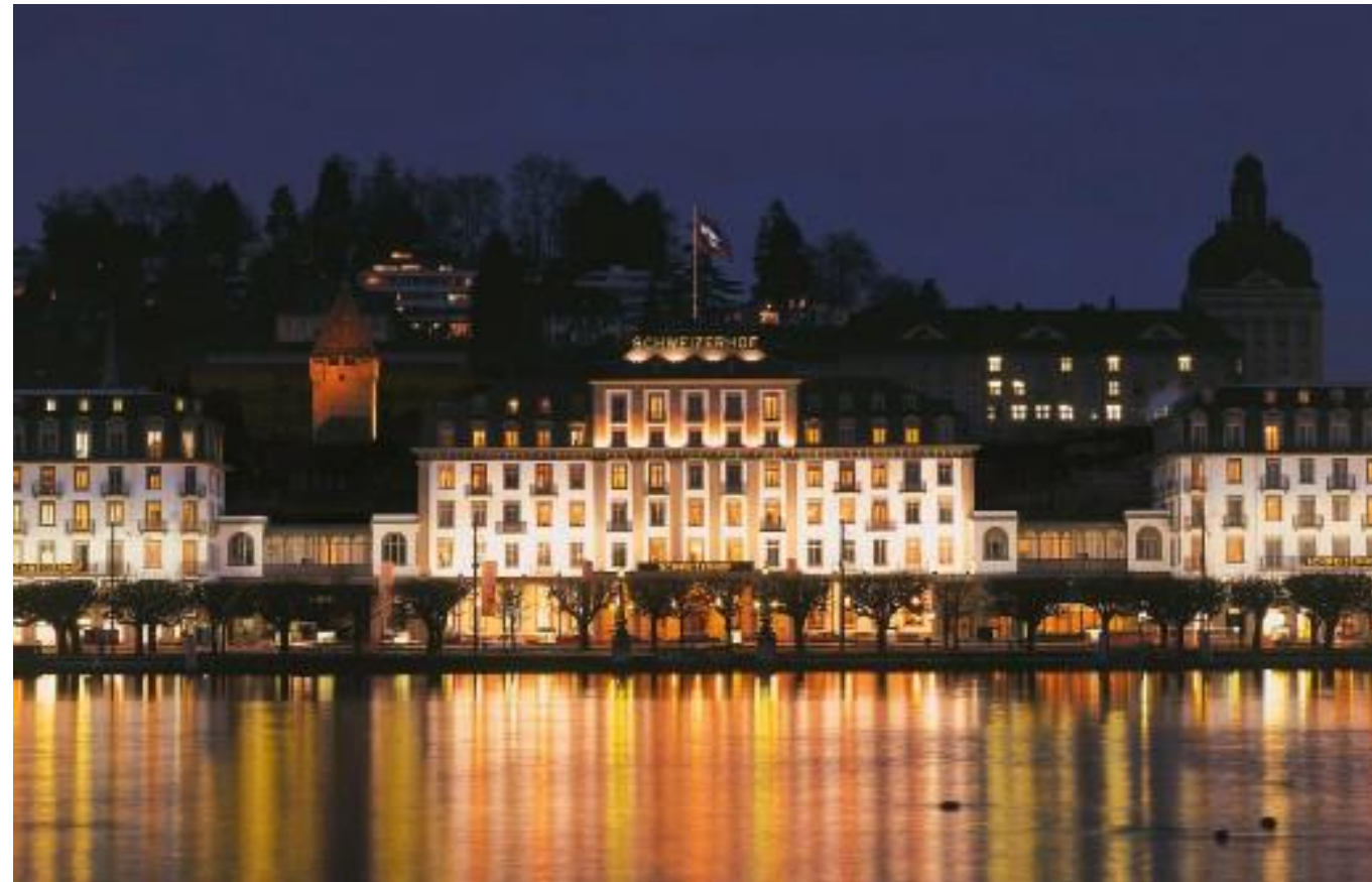
Hotel Schweizerhof, CH-Luzern Arquitecto: Guido Henzmann, LIGNO IN-RAUM AG, CH-Emmen Operador / Inversor: Familie Hauser, CH-Luzern
