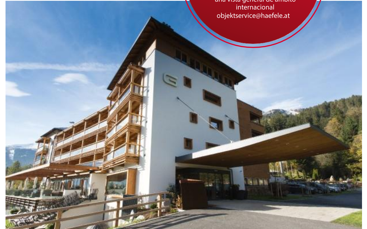
Hotel DAS.GOLDBERG, A-Bad Hofgastein Arquitectura: W2 Manufaktur GmbH, A-Leogang Operador: Familie Seer, A-Bad Hofgastein Inversor: DAS GOLDBERG GmbH & Co KG, A-Bad Hofgastein
